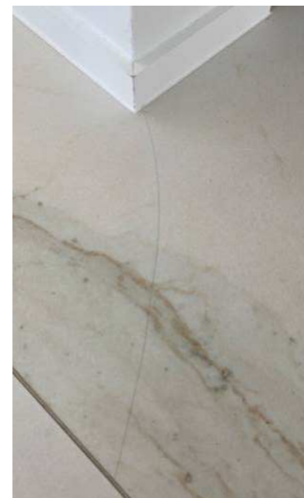
© Peter Goegebeur - Deze betegeling in een oogartsenpraktijk vertoont scheurtjes, waarop een expertise werd gevraagd.
